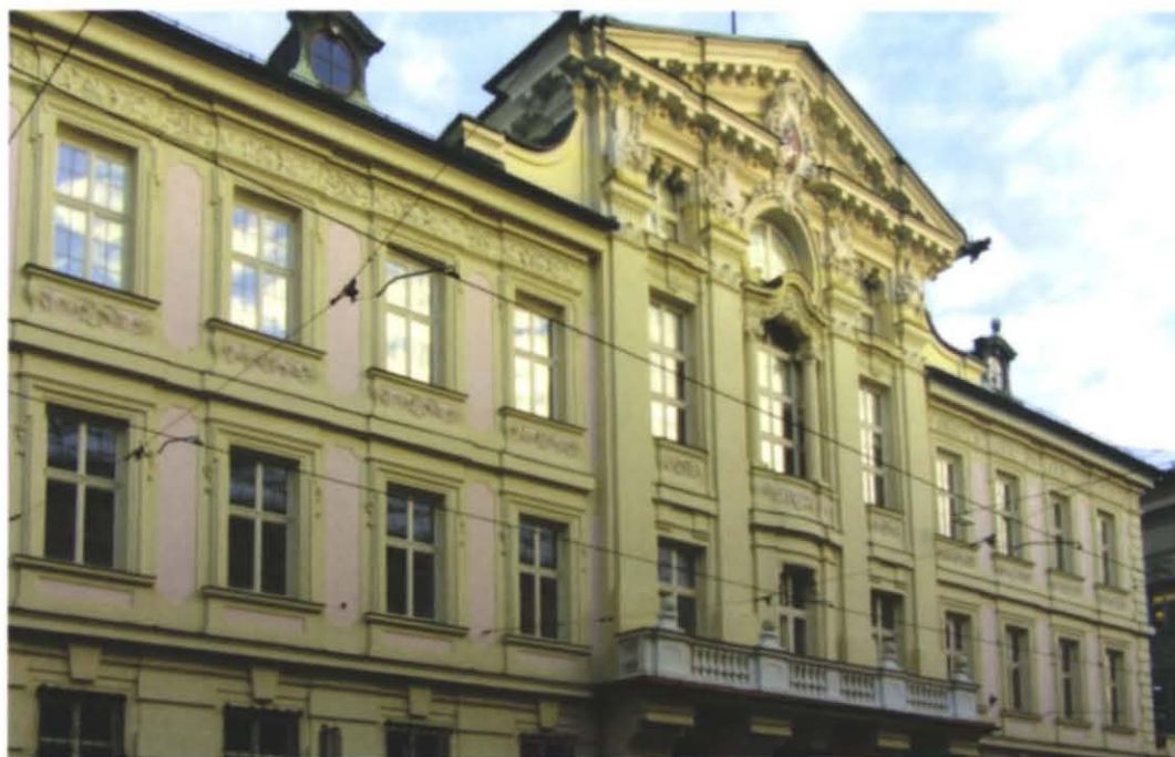
Innsbruck, Maria-Theresien-Straße 43, Landhausfassade © BDA / Hauser
