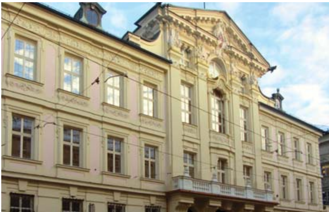
Innsbruck, Maria-Theresien-Straße 43, Landhausfassade © BDA / Hauser
