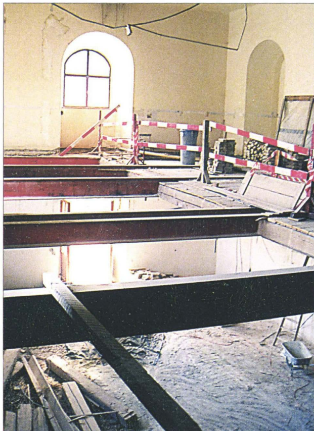
Abb. 2: Laienkirche: Zustand nach Abbruch der Zwischendecken
