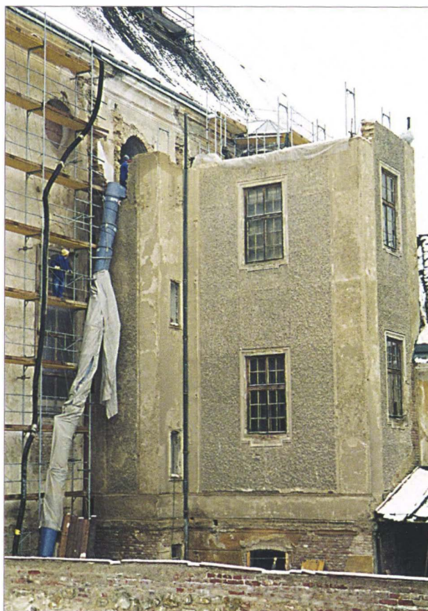
Abb. 1: Laienkirche: Abbruch des flankierenden Stiegenhauses
