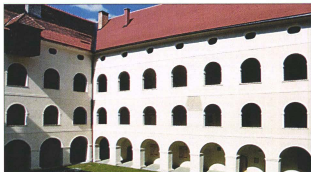
Abb. 4: Gurk, Propsteigebäude, Hof
