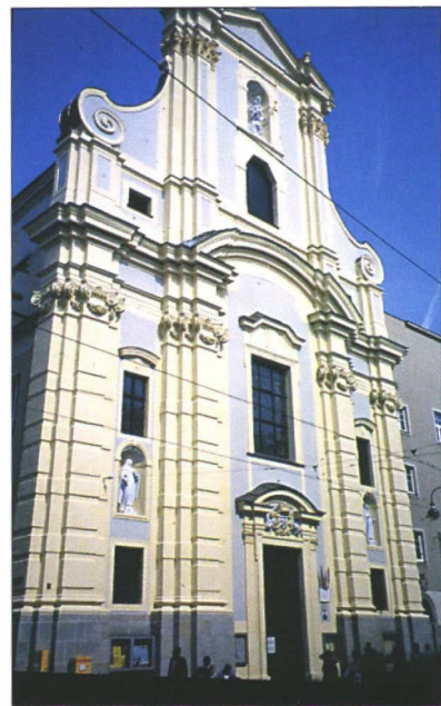
Abb. 5: Linz, Karmelitenkirche, Fassade an der Landstraße
