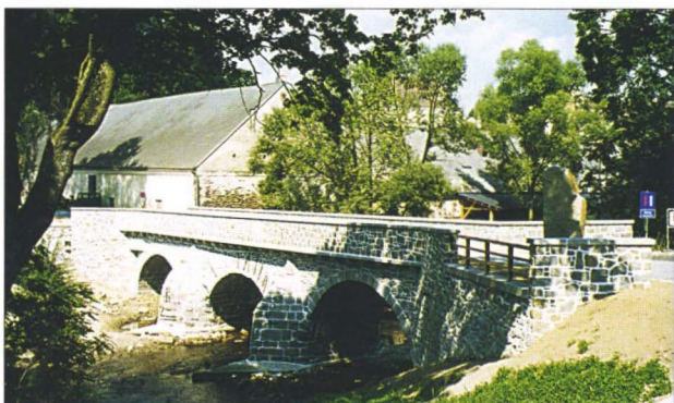
Abb. 1: Zwettl, Stift, mittelalterliche Steinbogenbrücke
