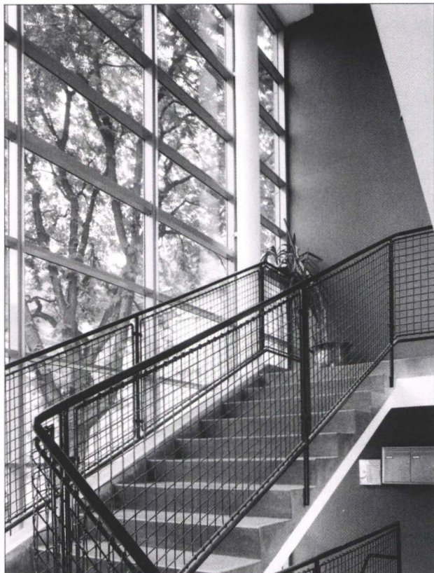
Abb. 14: ehem. Arbeitsamt Liesing, nach Restaurierung
