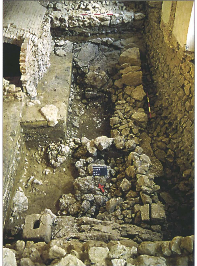
Abb. 1: Falkenstein, Pfarrhof. In der Bildmitte die ältesten Mauerreste aus dem 12. Jahrhundert, rechts davon die Ringmauer des 13. Jahrhunderts.
