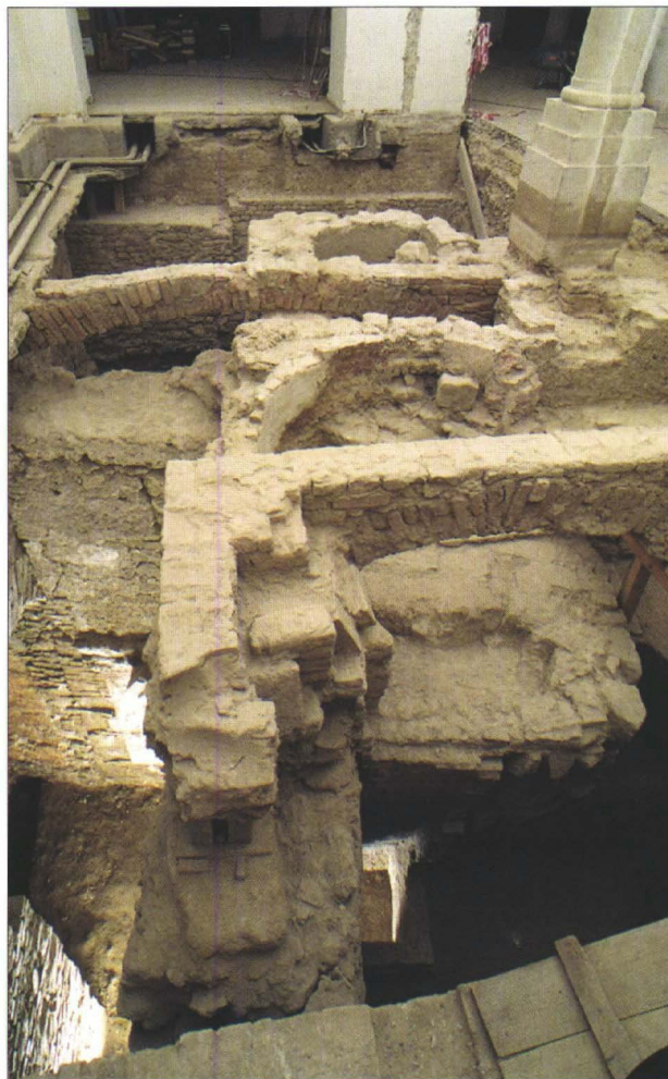
Abb. 10: Wien 1, Alte Universität, Bäckerstraße. Nördlicher Grabungsabschnitt von Osten. Unter einem Entlastungsbogen das Fundament einer Wendeltreppe, am rechten Bildrand eingeschossiger ziegelgewölbter Keller.
