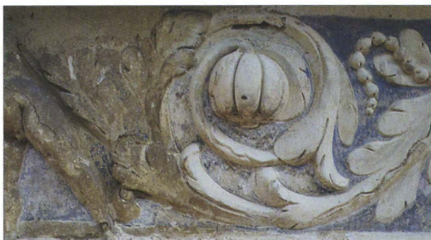
Abb. 3: Deutschkreuz, Schloss, Stuckfries an der südlichen Schlossfassade
