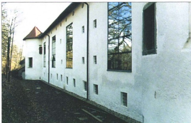
Abb. 9: Viktring, Stiftsanlage, ehem. Getreidespeicher
