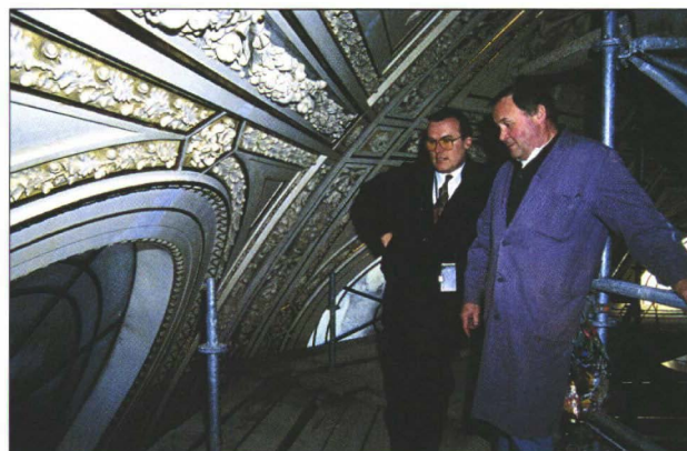
Tageslichtluken des Rundgewölbes
