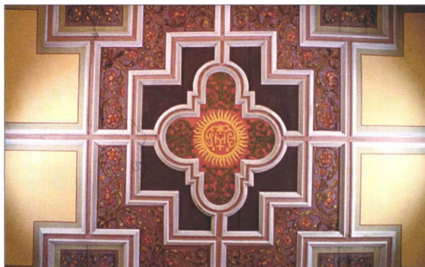
Abb. 6: Lermoos, Kapelle Maria Opferung, Kassettendecke nach Restaurierung
