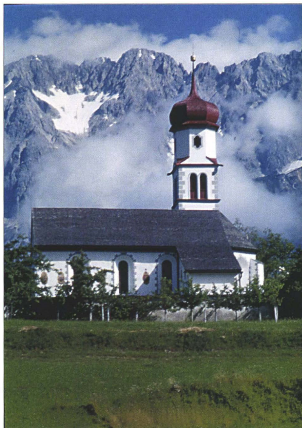
Abb. 10: Mieming, Filialkirche in Obermieming, Außenansicht
