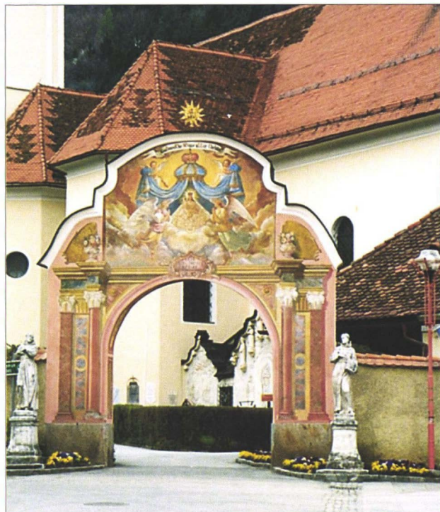
Abb. 4: Maria Lankowitz, Portal in der Kirchhofmauer nach Restaurierung
