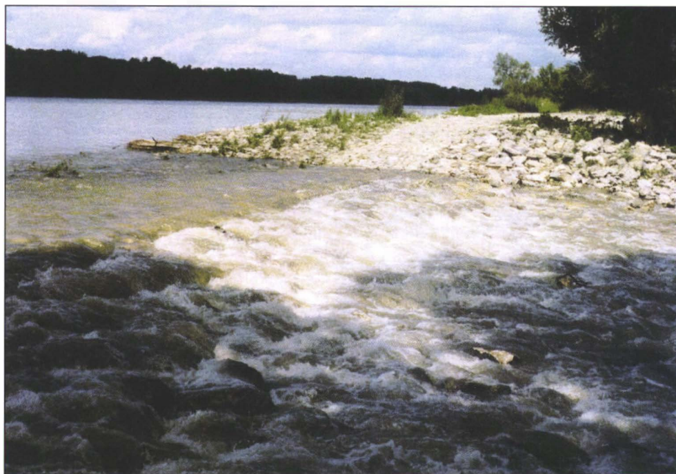
Gewässervernetzung – Treppelwegabsenkung an der Donau
