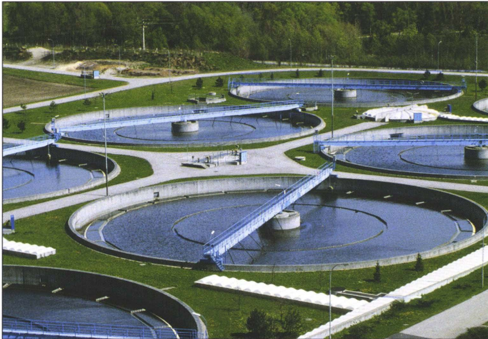
Nachklärbecken der Kläranlage Linz-Asten
