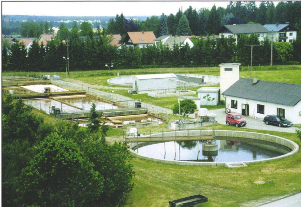
Kläranlage in Gmünd/NÖ
