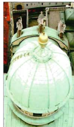
Abb. 4: Graz, Mausoleum, Blick auf die Dachlandschaft
