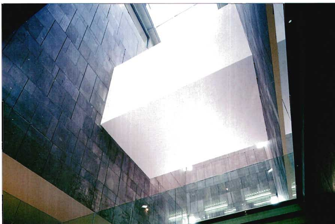
Heimo Zobernig, „Weißer Kubus“ (Umbau, überbrückende Raumverbindung zur Schaffung einer durchgehenden Sonderausstellungsebene)
