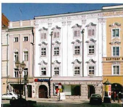
Abb. 6: Wels, Stadtplatz 41, Fassade
