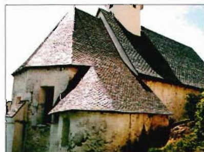
Abb. 5: Sörg, Pfarrkirche bl. Martin, Steinplattltdach
