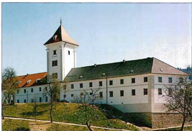
Abb. 5: Waldhausen, ehem. Stift, W-Fassade
