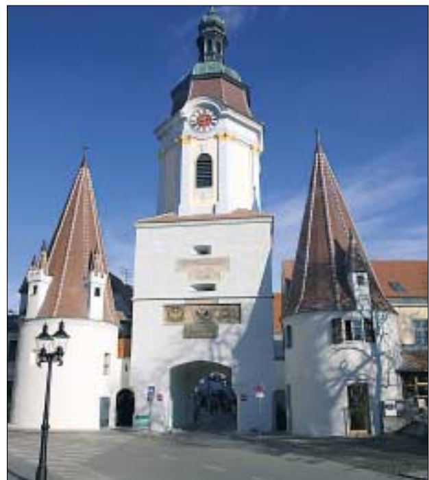
Abb. 3, 4: Krems, Steiner Tor, Dachneudeckung n. R.
