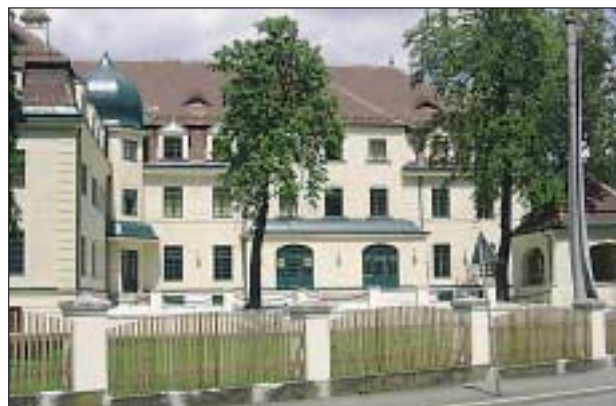
Abb. 3: Werksotel Leoben-Donawitz, ehem. Gästetrakt
