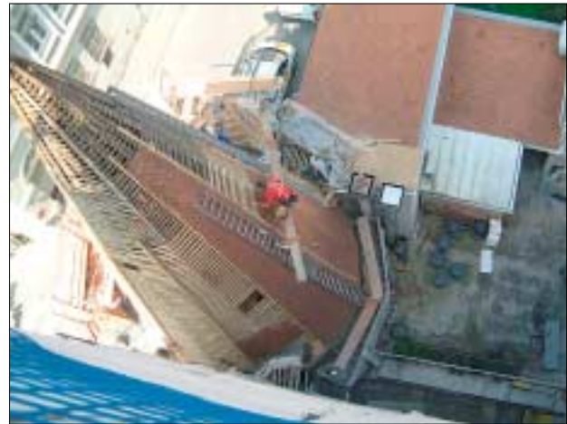
Abb. 3, 4: Krems, Steiner Tor, Dachneudeckung n. R.
