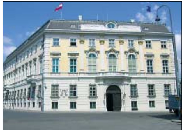
Abb. 3: Wien, Bundeskanzleramt nach Restaurierung
