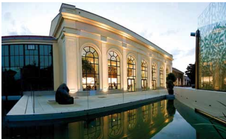
Orangerie nach Sanierung des Alten Palmenhauses, © Franz Zwickl
