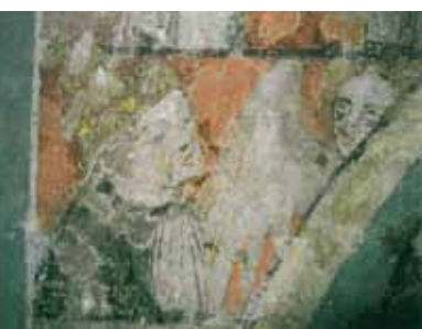
Pfarrkirche Reuthe, Chor Vorzustand und nach der Restaurierungsprobe, © Bizzarri Claudio
