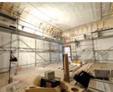
Baustelle Unteres Belvedere
