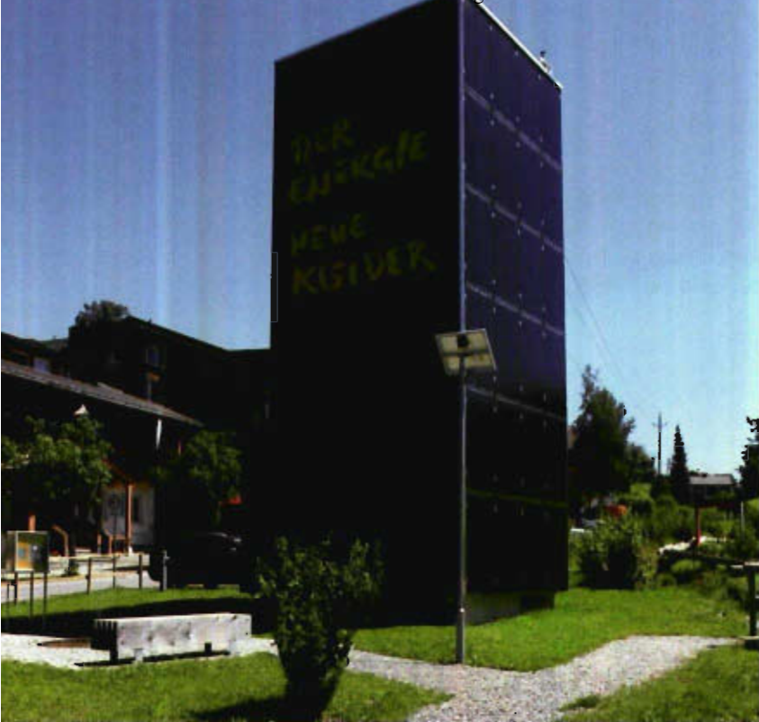
Umbau einer Trafostation zu einem Solar-Schaukraftwerk als Ausgangspunkt für den Energieweg in Langenegg, Vorarlberg (fink thurnher architekten, 2006)
