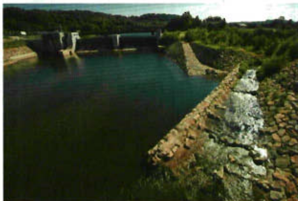
Wasserkraftwerk in Kimmelbach; rechts naturmaher Beckenpass
