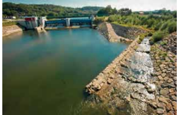
Wasserkraftwerk in Kimmelbach; rechts naturnaher Beckenpass
