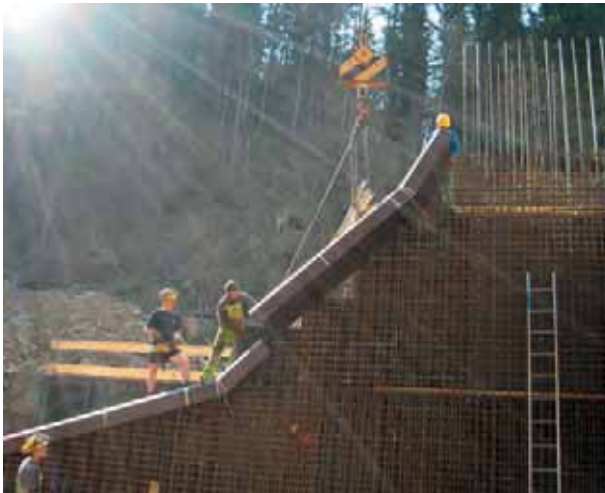
2012 betrugten die Aufwendungen für die Wildbach- und Lawinerverbauung rund 140 Mio. Euro.
