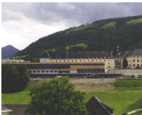
Der Neubau des Internats in Raumberg-Gumpenstein mit 114 Internatsplätzen und einer Doppelturnhalle wurde im August 2016 fertiggestellt.
