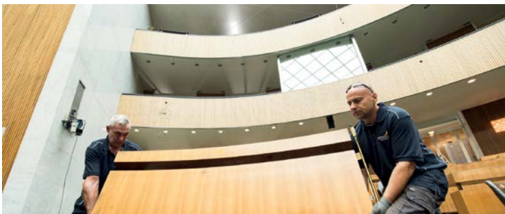
Abbau des Inventars im Plenarsaal des Parlamentsgebäudes
