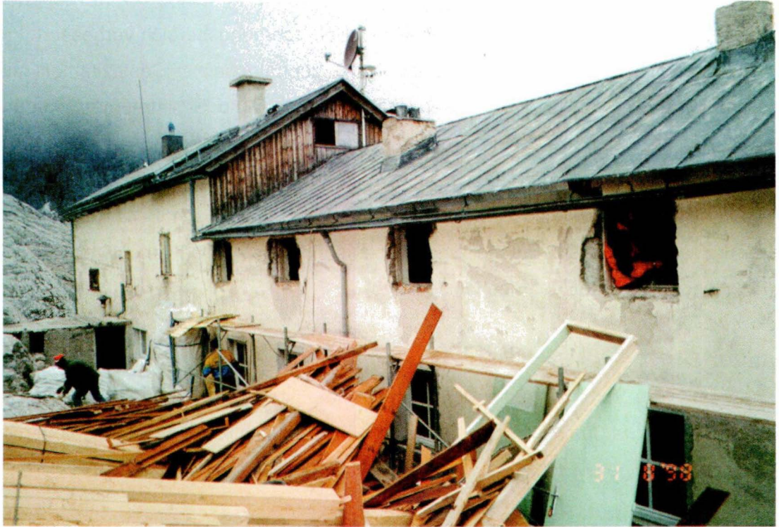
Abb. 66: Südfassade während des Umbaus
