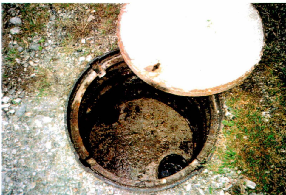
Abb. 32: Fettabscheider vor dem Abschöpfen der Schwimmstoffe
