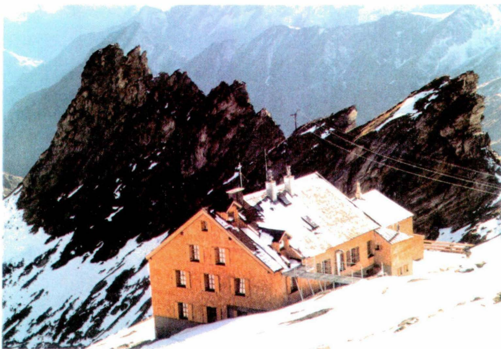
Abb. 50: Defregger Haus nach der Sanierung (1994)
