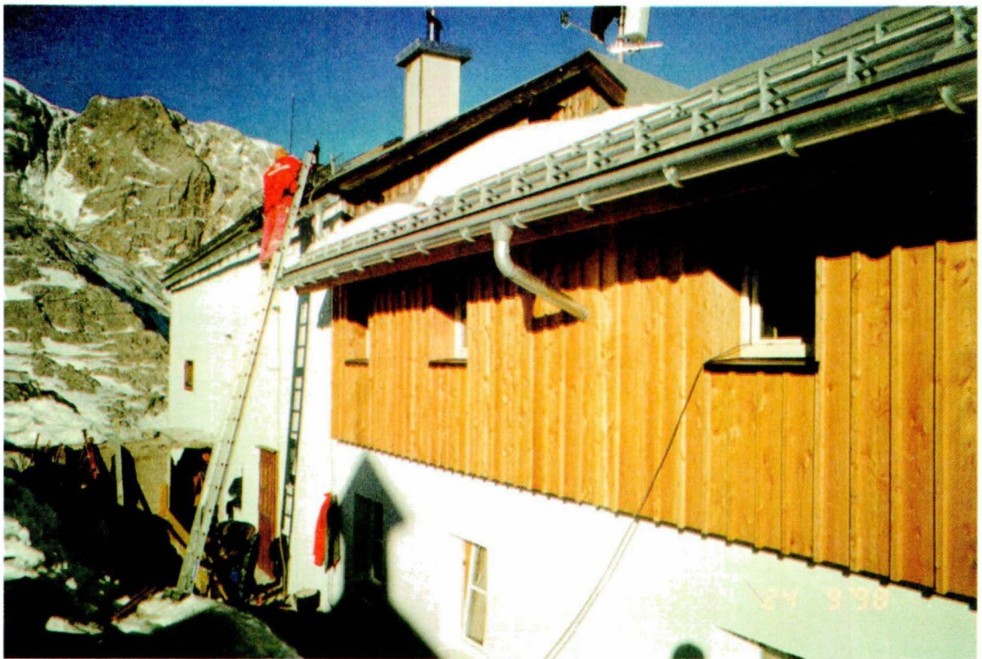
Abb. 67: Südfassade nach dem Umbau
