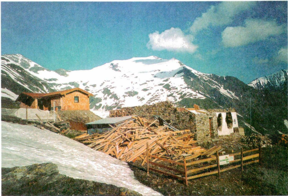
Abb. 93: Abbruch des Naturfreundehauses Neubau
