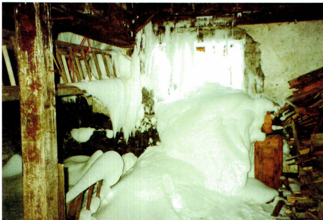
Abb. 53: Schneeintrag in den nicht nutzbaren Räumen
