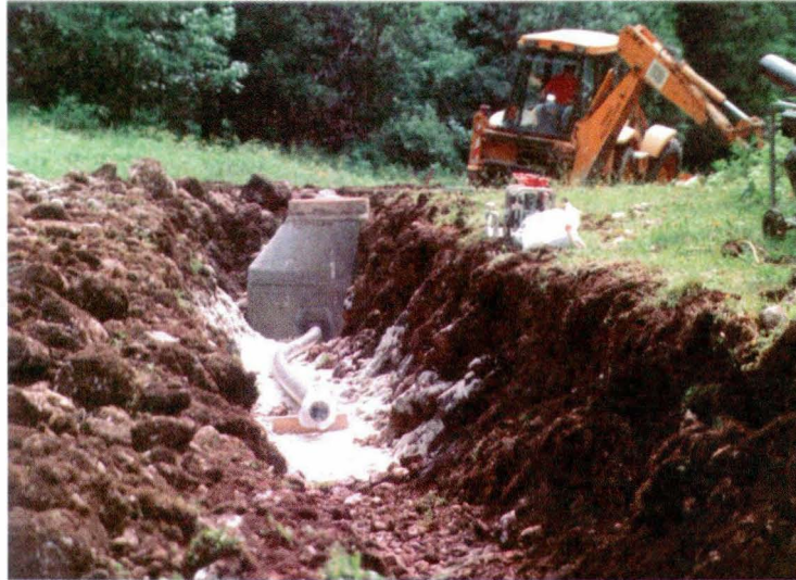
Abb. 51: Kanalbauarbeiten Sparbacher Hütte
