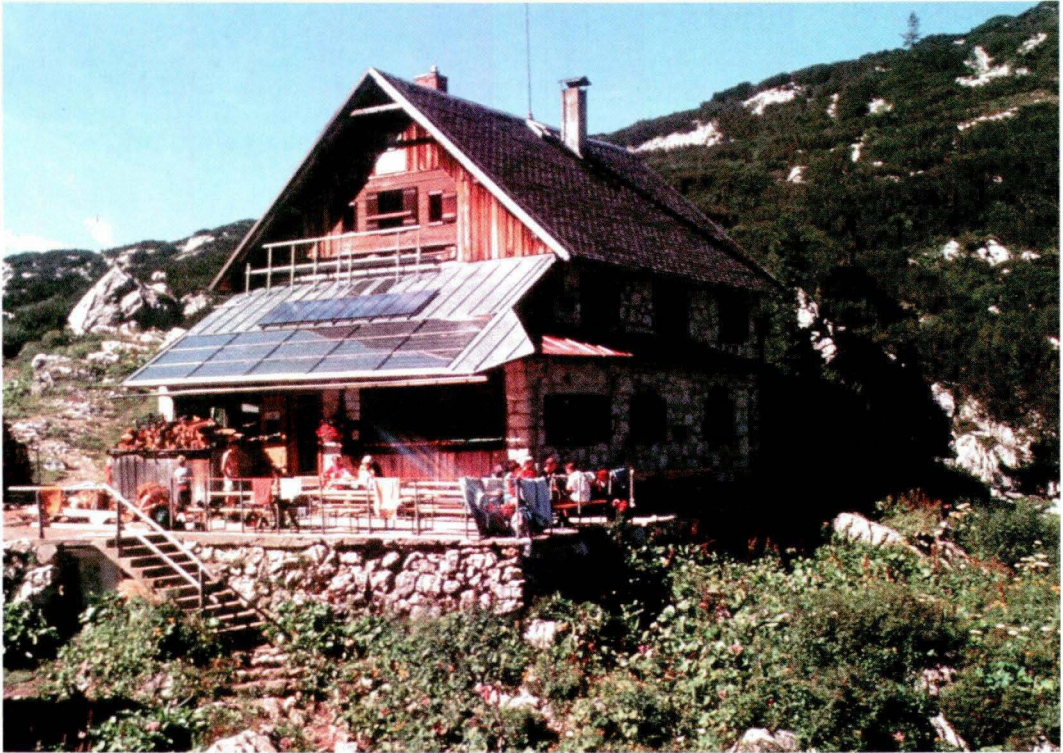
Abb. 24: Sonnenkollektoren Pühringer Hütte
