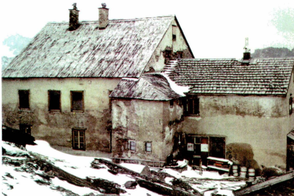
Abb. 49: Defregger Haus vor der Sanierung
