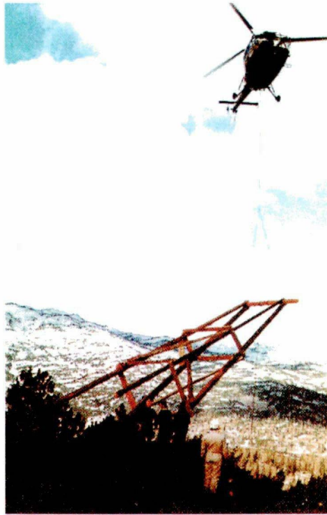
Abb. 115: Bau der Materialseilbahn: Hubschraubertransport
