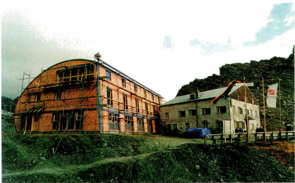
Abb. 22: Alte und neue (links) Stüdlhütte
