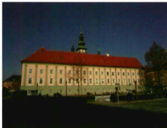
Abb. ganz links: Maria Saal, Propsteipfarr- und Wallfahrtskirche Mariae Himmelfahrt , Nordturm während der Restaurierung © Diözese Gurk Abb. links: Klagenfurt, Landhaus nach Neueindeckung und Fassadenfärbelung © Architekturbüro Omansiek
