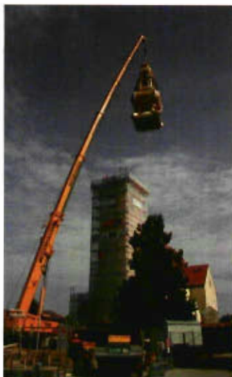
links: Gunskirchen, Wiederaufsetzen des restaurierten Turmhelmes der Pfarrkirche © Schöffmann rechts: Ottensheim, Marktplatz 7, Neues Amtshaus © BDA
