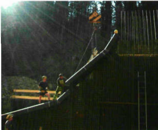
2012 betrugen die Aufwendungen für die Wildbach- und Lawinenverbauung rund 140 Mio. Euro.
