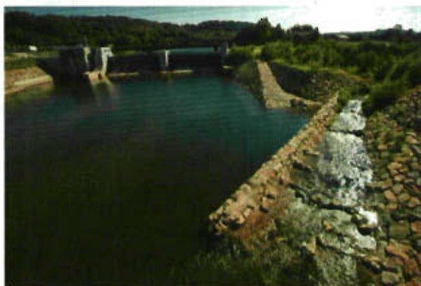
Wasserkraftwerk in Kammelbach; rechts naturnaher Beckenpass
