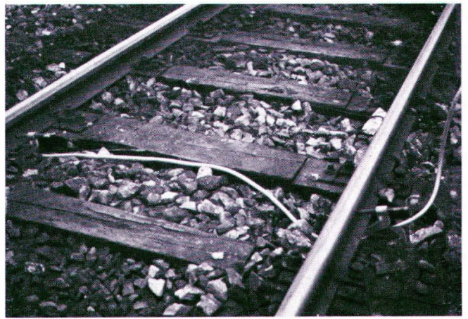
Abb. 12: Für bestimmte Bahnhöfe mit Isolierschienen werden Erdungsstangen mit zwei Schraubklemmen verwendet, womit die Erdung an beiden Schienen eines Gleises erfolgt.
