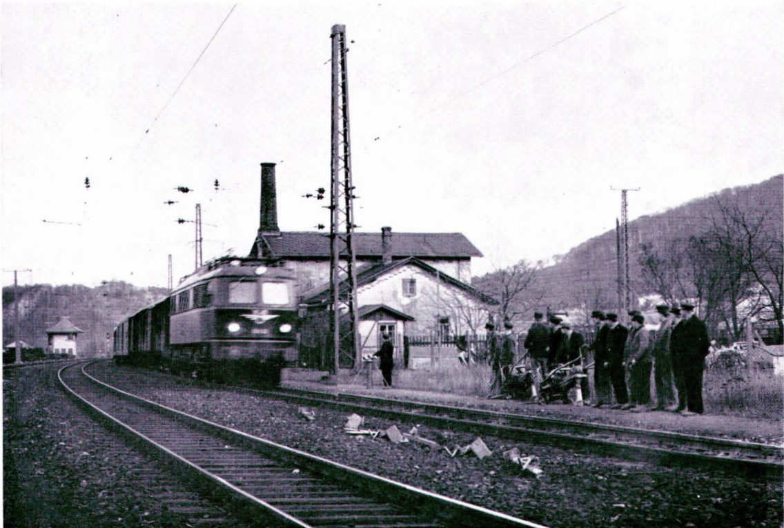
Abb. 7: Die Arbeitsgruppe ist zeitgerecht ausgetreten und erwartet die Zugfahrt am Randweg stehend ab. Die Arbeitsgeräte sind sicher abgelegt.
