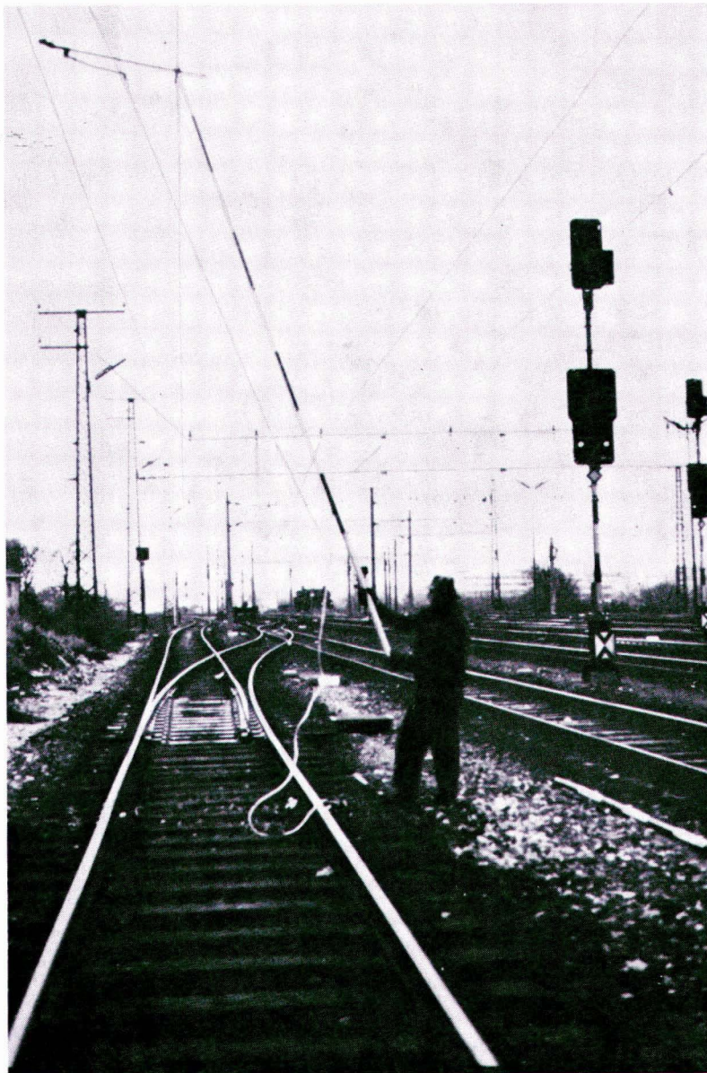
Abb. 11: Anschließend wird die Stange in die zu erdende Leitung eingehängt. Es darf jeweils nur eine Person erden.
