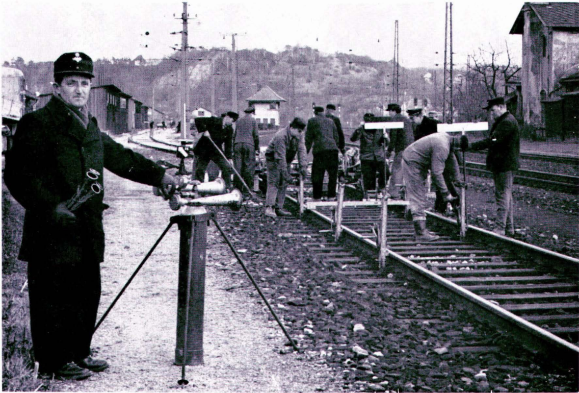
Abb. 6: Die Sicherung einer mit Kraftgeräten arbeitenden Oberbaurotte: Wegen der Verwendung lärmender Geräte ist der Sicherungsposten mit einem Typhon ausgerüstet.
