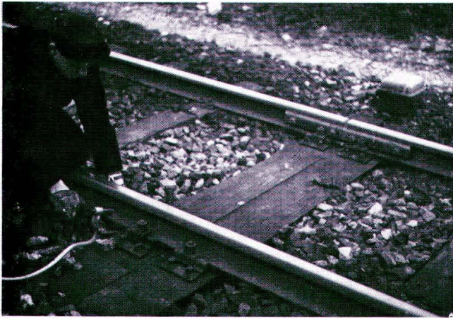
Abb. 10: Geerdet wird durch Befestigung der Schraubklemme an einem gutgeerdeten Anlageteil (Schiene).
