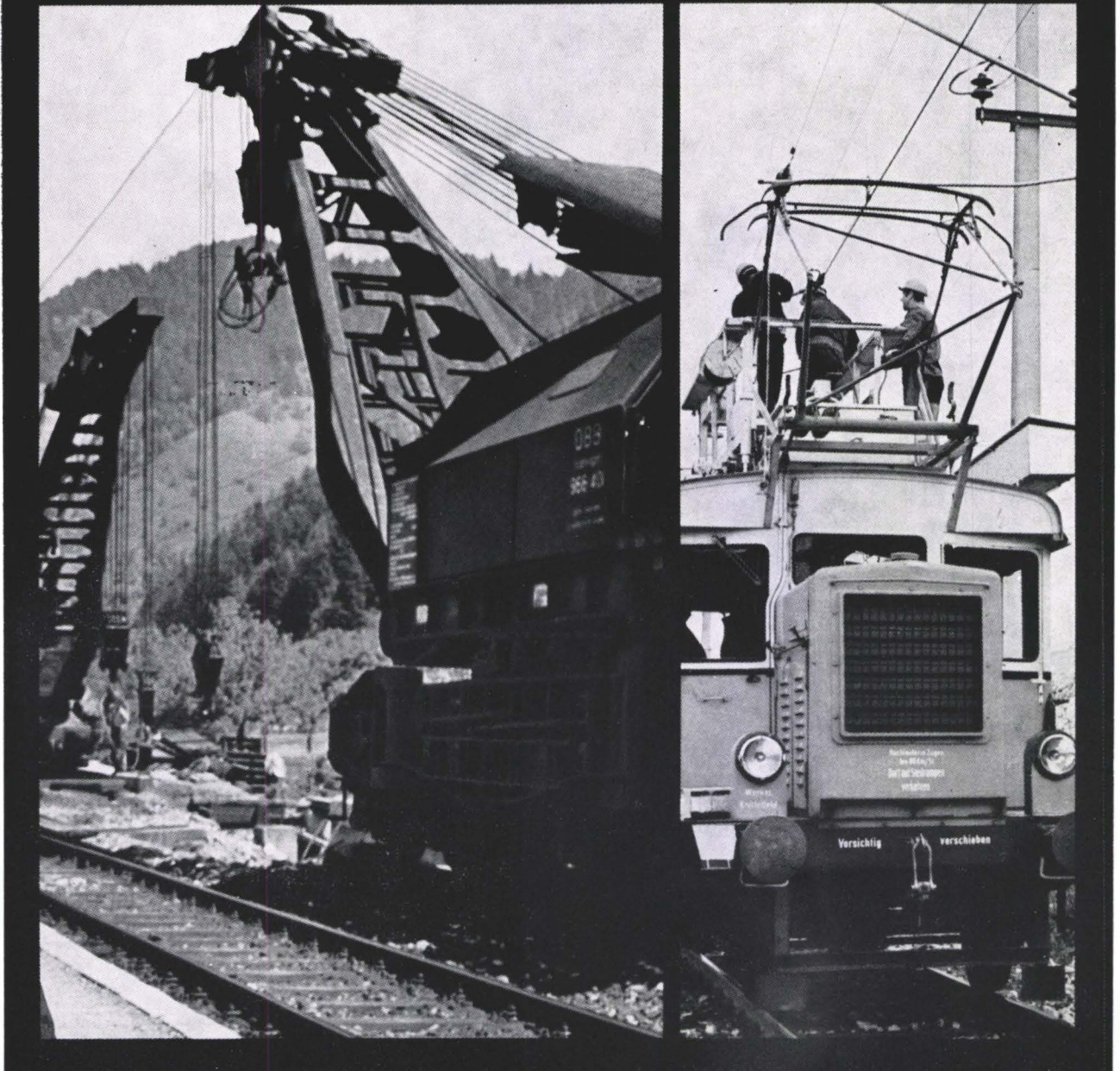
Abb. 14 und 15: Bei Bau- und Betriebsarbeiten besteht erhöhte Unfallgefahr. Um Kopf-, Hals- und Nackenverletzungen zu vermeiden, tragen die Dienstnehmer auf der Arbeitsbühne des Motorturmwagens Schutzhelme
