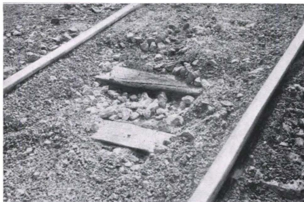
Abb. 5: Solche Löcher im extremen Verschubbereich können zu Unfällen der dort tätigen Dienstnehmer führen
