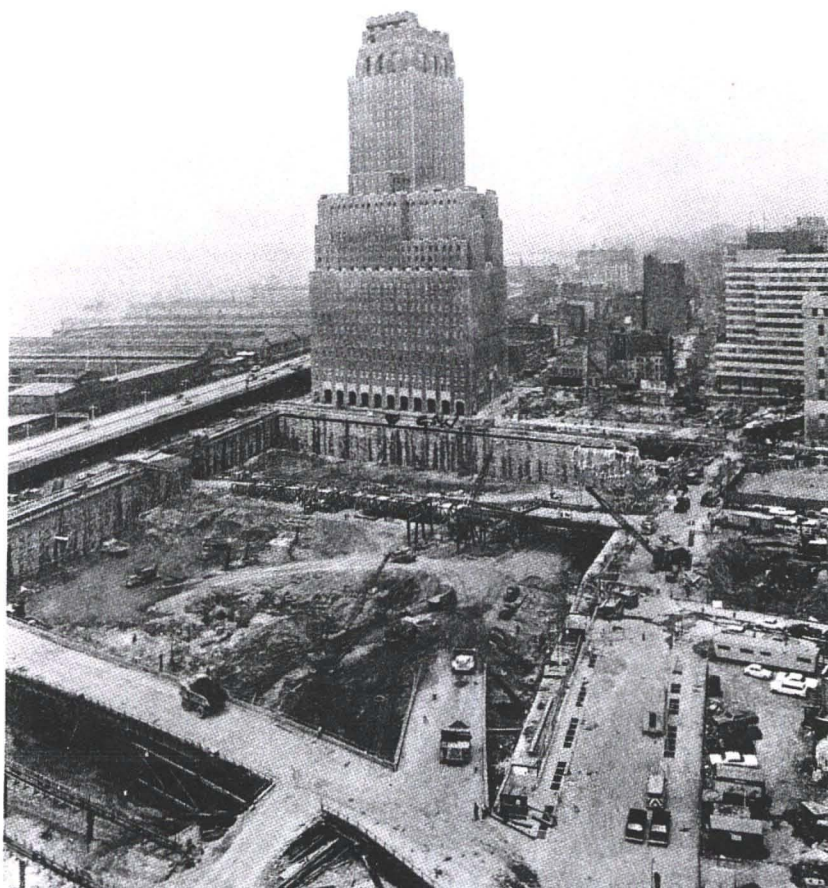
Abb. 1: Anwendung des von Ch. Veder entwickelten „Schlitzwandverfahren“ beim Bau des New York World Trade Center.
