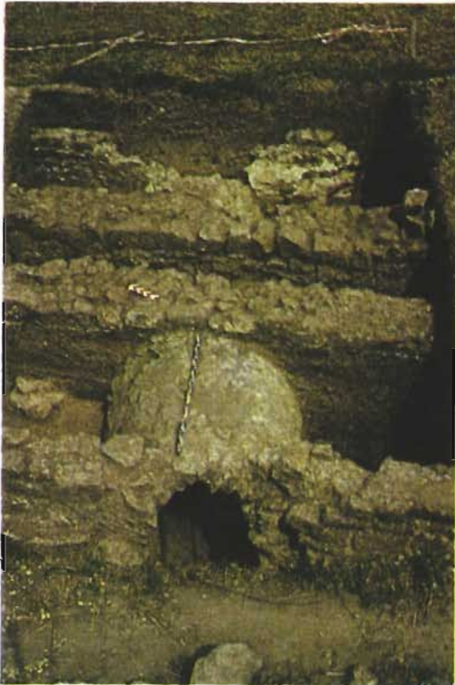
Abb. 20a: Begehbare Gewölbe über einer römischen Wasserleitung zur Kontrolle des die Wasserleitung überkreuzenden Abwasserkanals des Kastells.
