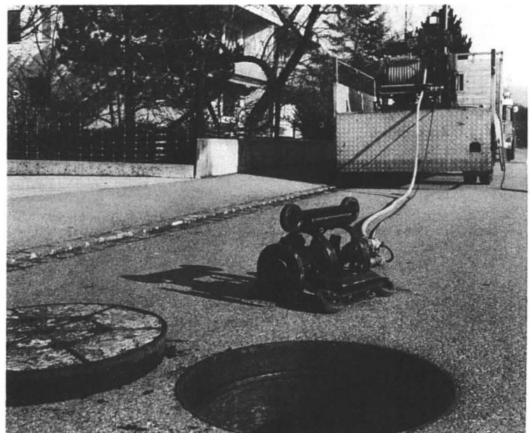
**Gerät zur Sanierung undichter und poröser Kanäle und Rohrleitungen:**
