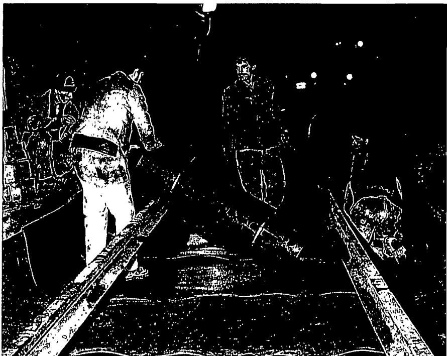
Die Matten werden unter dem Schotterbett der Geleise verlegt
