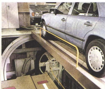
Mechanische Garagen (Paternostersystem) sparen Platz. Sie eignen sich beispielsweise zur Lösung des Parkproblems in dicht verbauten Wohngebieten. Neben der Vermeidung von Lärm- und Abgasemissionen bieten mechanische Garagen Fahrzeugen und Lenkern hohe Sicherheit.
