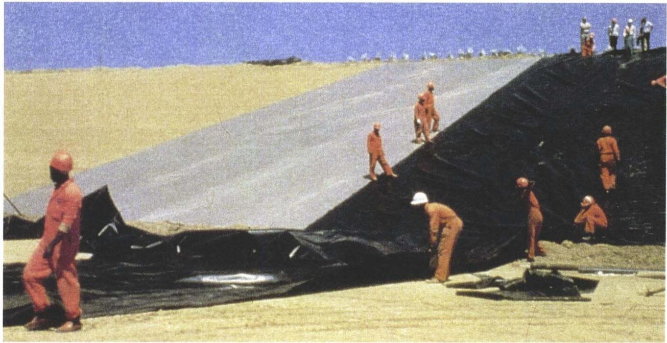
**G**eotextilien haben eine stürmische Entwicklung hinter sich: Binnen rund 20 Jahren haben sich die neuen Werkstoffe einen festen Platz bei der Baugrundstabilisierung, im Erosionsschutz, bei der Drainagierung, Hangstabilisierung und Asphaltverstärkung erobert. Heute sind Geotextilien insbesondere aus dem Arsenal der Tiefbauingenieure nicht mehr wegzudenken.
