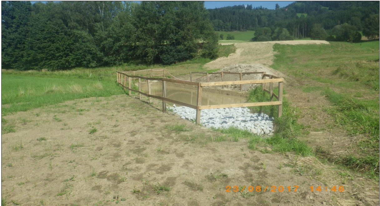
Abbildung 4: Absetzbecken am Fuße des Hangs
