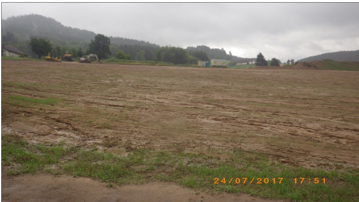
Abbildung 2: Humusierte Fläche, Blickrichtung Süd-West während des Niederschlags
