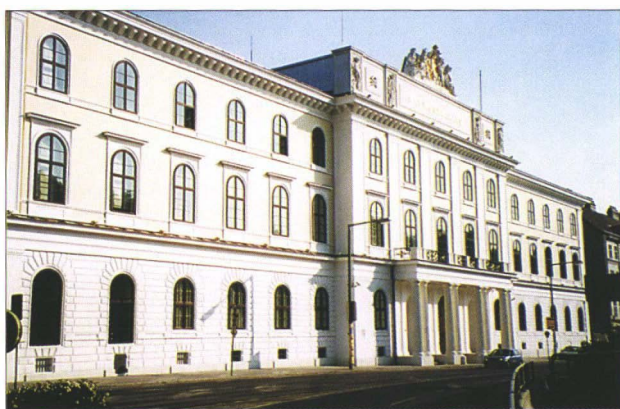
Abb. 8: Hauptmünzamt, Fassade nach Restaurierung
