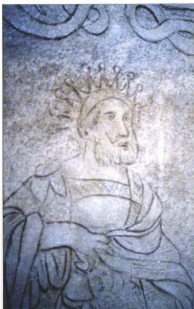
Abb. 5: Eggenburg, Sgraffitobaus, Detail der Fassade
