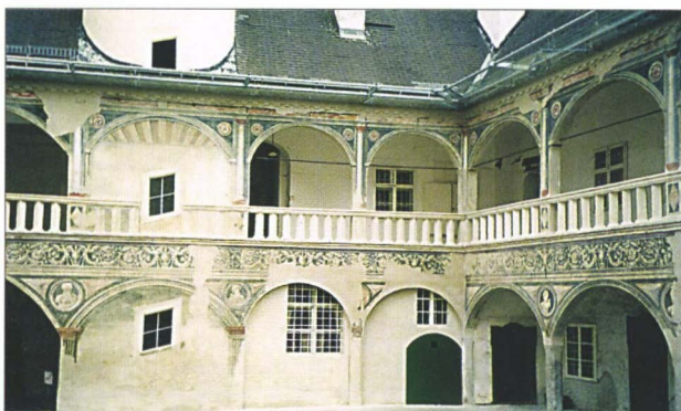
Abb. 13: Pöggstall, Schloss, Innenhof nach Restaurierung
