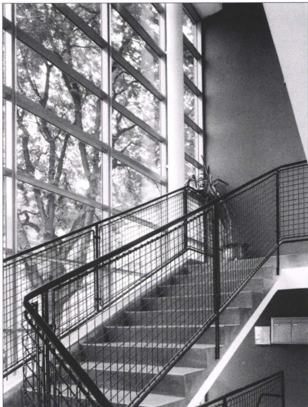
Abb. 14: ehem. Arbeitsamt Liesing, nach Restaurierung
