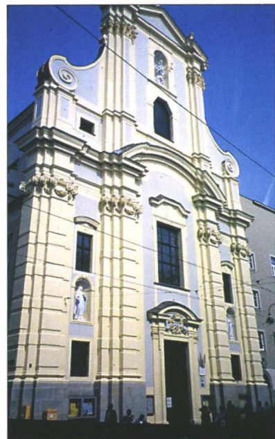
Abb. 5: Linz, Karmelitenkirche, Fassade an der Landstraße
