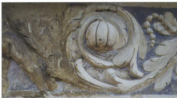
Abb. 3: Deutschkreuz, Schloss, Stuckfries an der südlichen Schlossfassade
