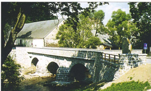
Abb. 1: Zwettl, Stift, mittelalterliche Steinbogenbrücke
