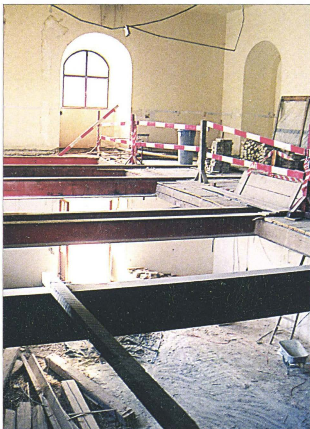
Abb. 2: Laienkirche: Zustand nach Abbruch der Zwischendecken
