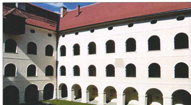
Abb. 4: Gurk, Propsteigebäude, Hof
