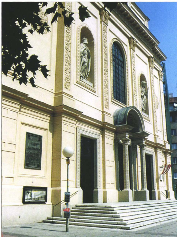
Abb. 7: St. Johann von Nepomuk, Fassade nach Restaurierung
