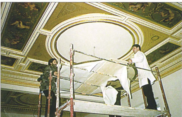
Abb. 1: Wien I, Schottenring 10, Deckengemälde (Marouflagetechnik), Wiederaufbringung
