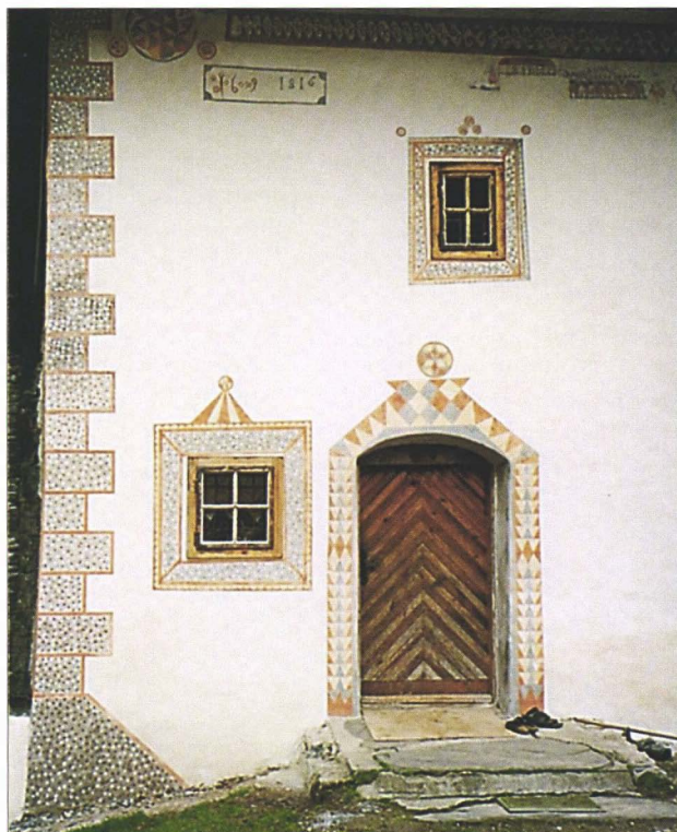
Abb. 3: Graden, sog. Ritterhaus
