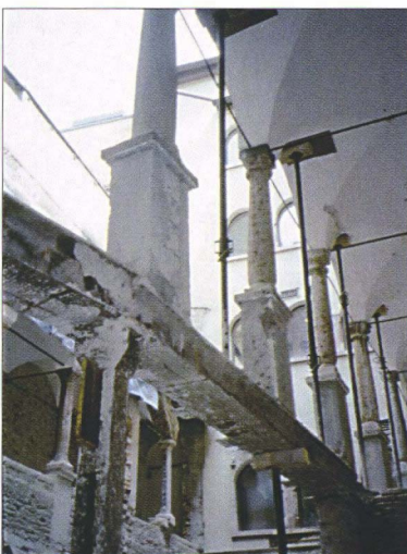
Abb. 3: Salzburg Stadt, Getreidegasse 10, Arkadenhof nach Freilegung
