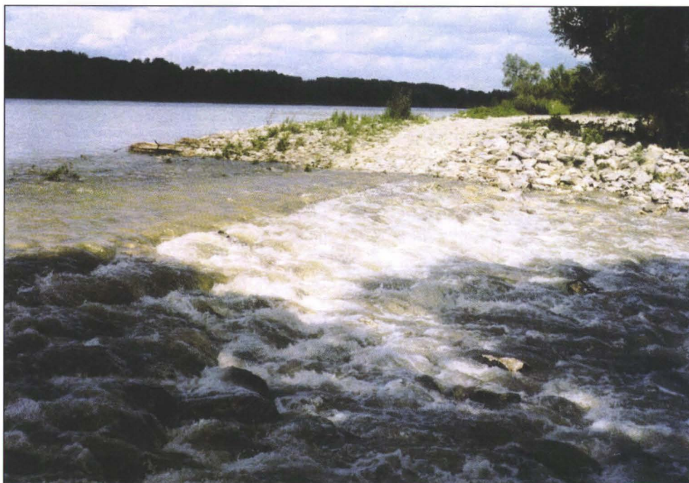
Gewässervernetzung – Treppelwegabsenkung an der Donau
