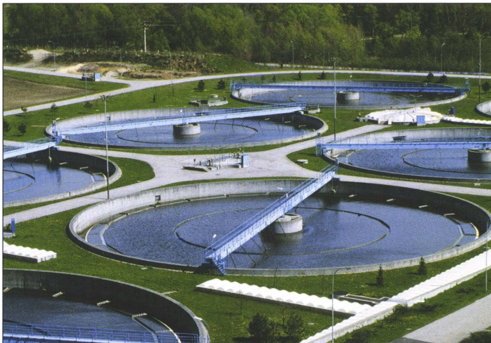
Nachklärbecken der Kläranlage Linz-Asten
