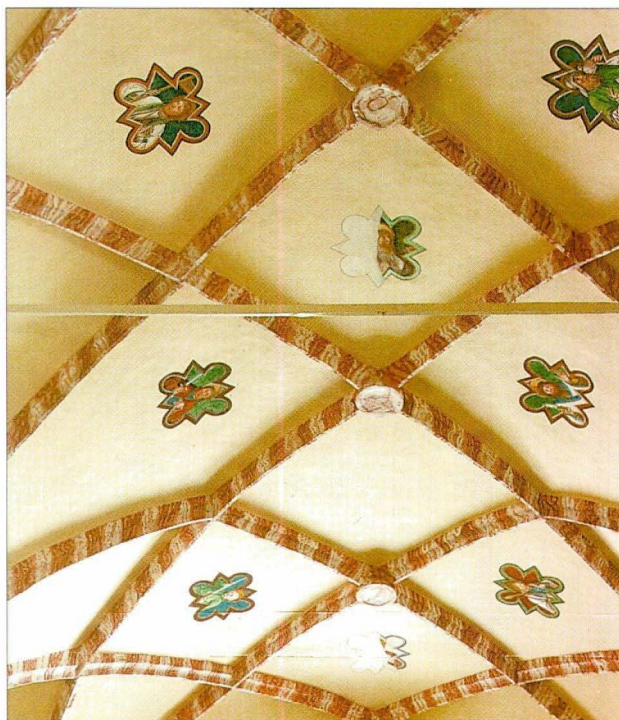
Abb. 4: Radendorf, Maria Siebenbrunn, Langhausgewölbe mit spätgotischen Vierpässen und Rippendekor, 1849
