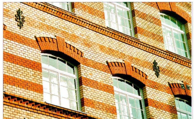
Abb. 1: Wien 6., Gumpendorfer Straße 132, nach Sanierung
