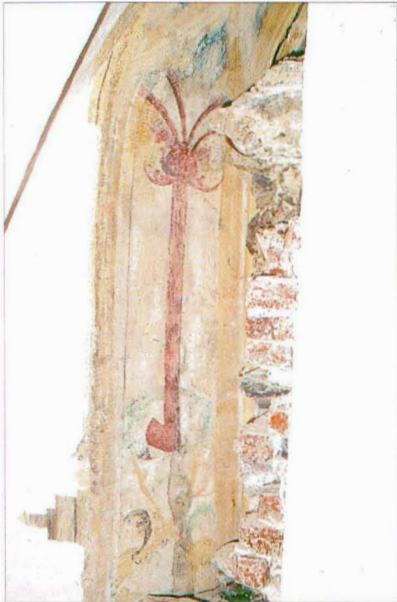
Abb. 4: Pöggstall, ehem. Schlosskapelle, S-Wand, nach Restaurierung
