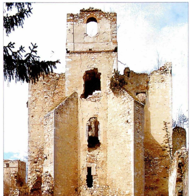
Abb. 2: Landsee, Hochburg, Westansicht, vor Restaurierung
