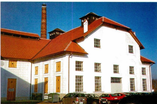
Abb. 4: St. Florian, ehem. Glockengießerei
