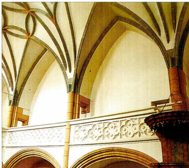
Abb. 1: Eberndorf, ehem. Stiftskirche, Langhaus mit freigelegter spätgotischer Maßwerkbrüstung
