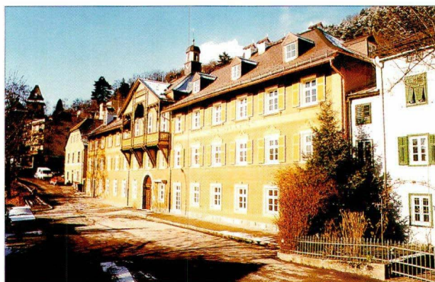
Abb. 1: Innsbruck, Anton-Rauch-Straße 30, ehem. Badehaus in Mühlau
