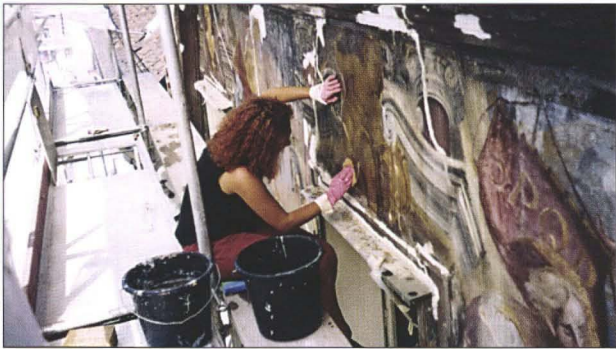
Abb. 3: Graz, Herrengasse 3, Gemaltes Haus, Reinigung, Festigung und Verkittung
