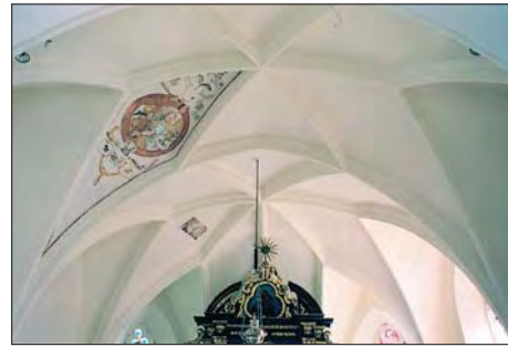
Abb. 4: Hof/Dvor, Filialkirche, Blick ins Gewölbe
