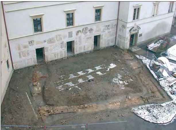
Abb. 3: Seggau, Schloss, Fundamente des „Alten Turmes“
