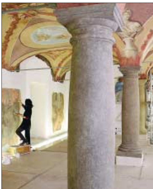
Abb. 6: Palais Modena, Sala Terrena, Freilegung
