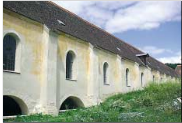
Abb. 2: Kreuzgarten, W-Fassade n. R.
