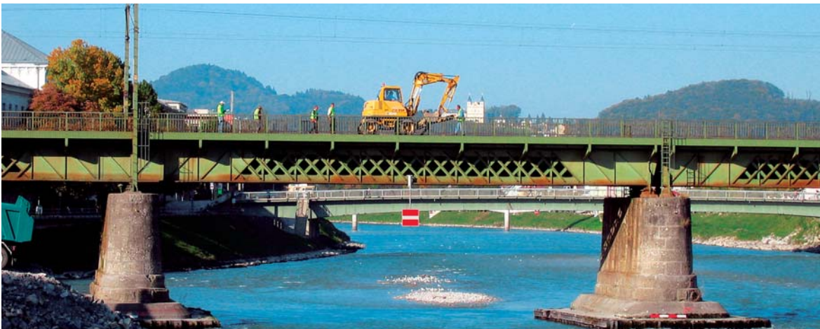
Neubau der Salzach-Brücke in Salzburg
