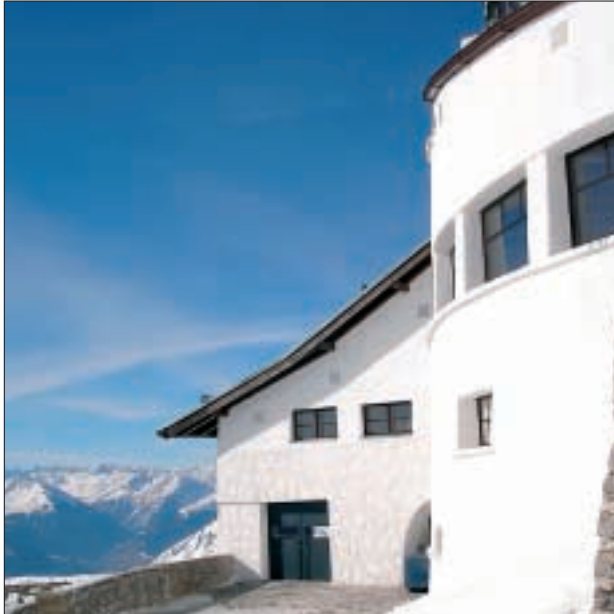
Abb. 3: Innsbruck, Nordkettenbahn, Bergstation
