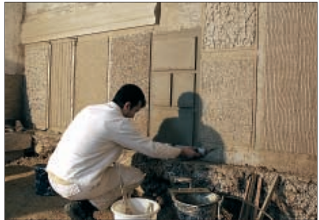
Abb. 1: Kurs Putzfassaden um 1900, Musterflächen
