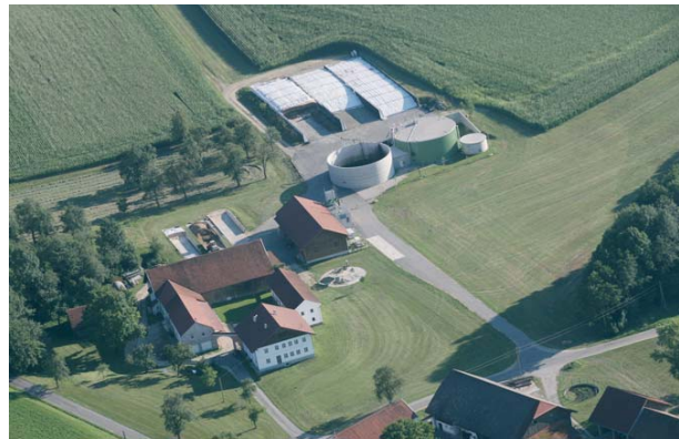
Biogasanlage in Mehrnbach, Oberösterreich, Agrar Portal
