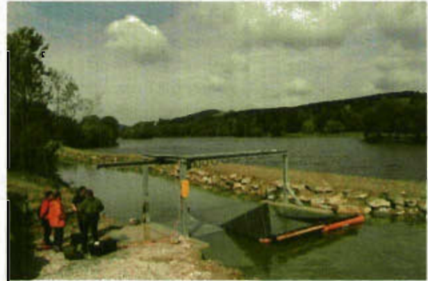
Fischaufstiegshilfe beim Kraftwerk Melk - Funktionskontrolle
