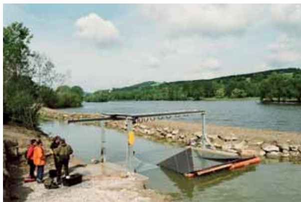
Fischaufstiegshilfe beim Kraftwerk Melk - Funktionskontrolle
