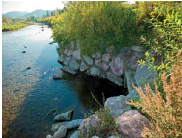
Das Investitionsvolumen für Schutzwasserbaumaßnahmen betrug 2011 insgesamt 145 Mio. Euro.
