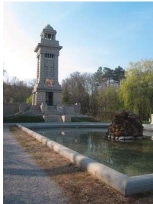
Bruckneudorf, Kriegerdenkmal (1916/17) nach Restaurierung © BDA, Falkner
