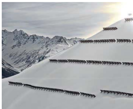
Der Lawinenschutz ist eine unverzichtbare Maßnahme zur Absicherung von Dauersiedlungsgebieten.
