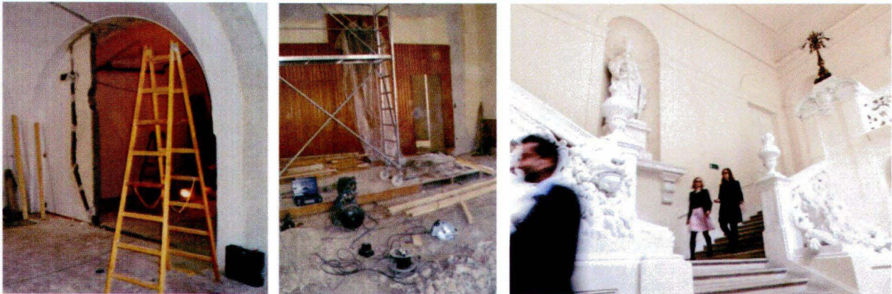
Renovierungsarbeiten und Umbaumaßnahmen in der Böhmisches Hofkanzlei; Löwenstiege im neuen Glanz (rechts)
