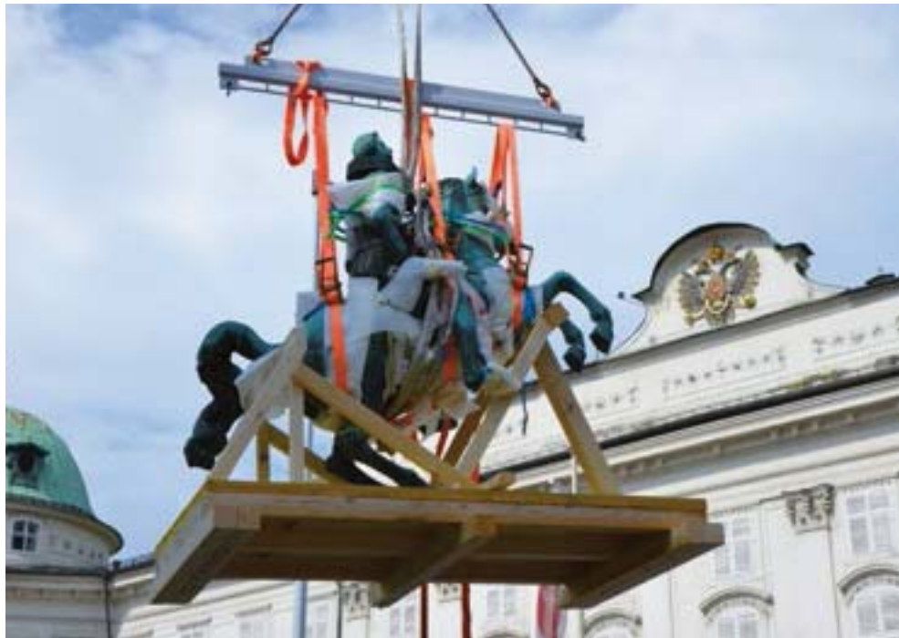
Leopoldsbrunnen, Innsbruck, Tirol, Demontage der Bronzefigur Erzherzog Leopold
