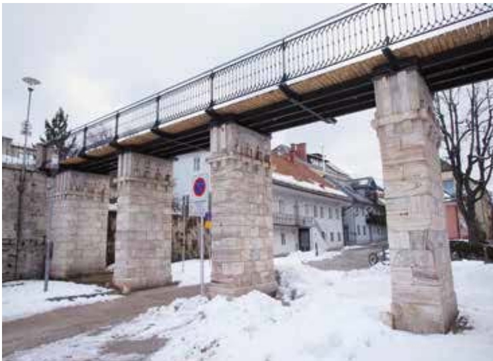
Klagenfurt, Elisabethbrücke nach Restaurierung
