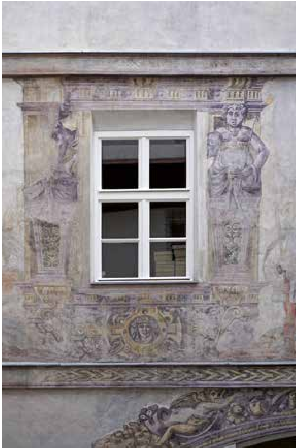
Damenstift, Innenhof, Detail Südwand nach Restaurierung
