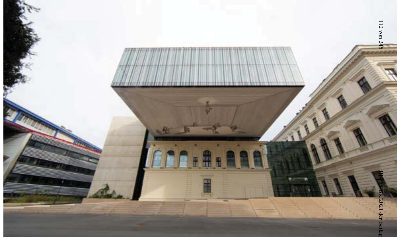
Anna Artaker, Perspectiva Practica an der Unterseite des Erweiterungsbaus der Universitätsbibliothek in Graz
