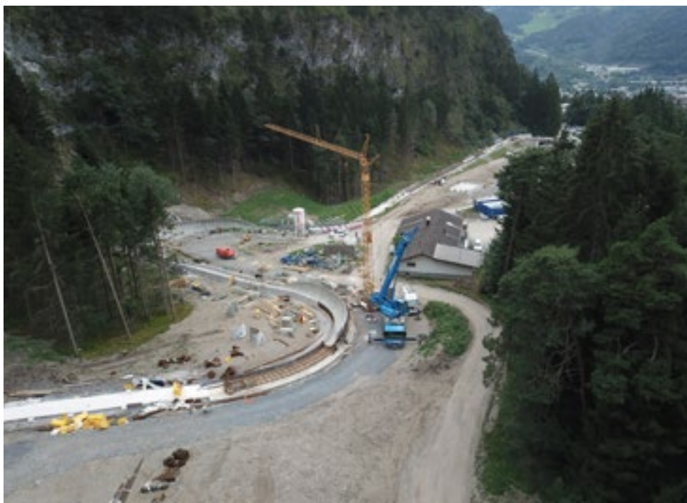
Eiskanal Bludenz während der Bauarbeiten im Jahr 2020.
