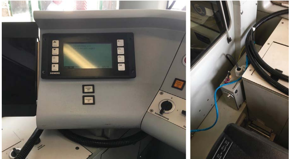
Abbildung 13: In einer Straßenbahn verbaute Onboard-Unit und ein Display zur Visualisierung von C-ITS-Daten der Firma Kapsch © Wiener Linien
