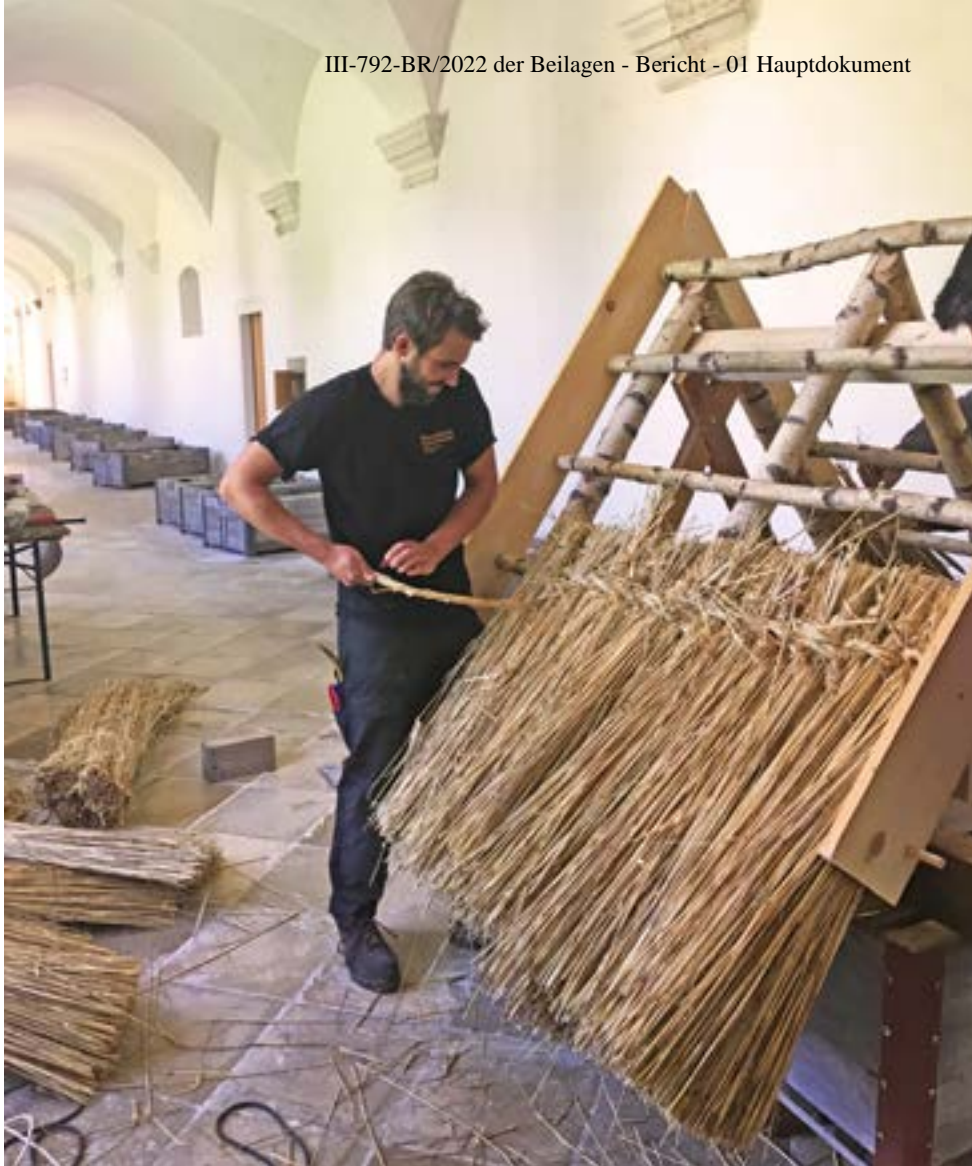
Strohdachdeckung, Kreuzgang der Kartause Mauerbach
