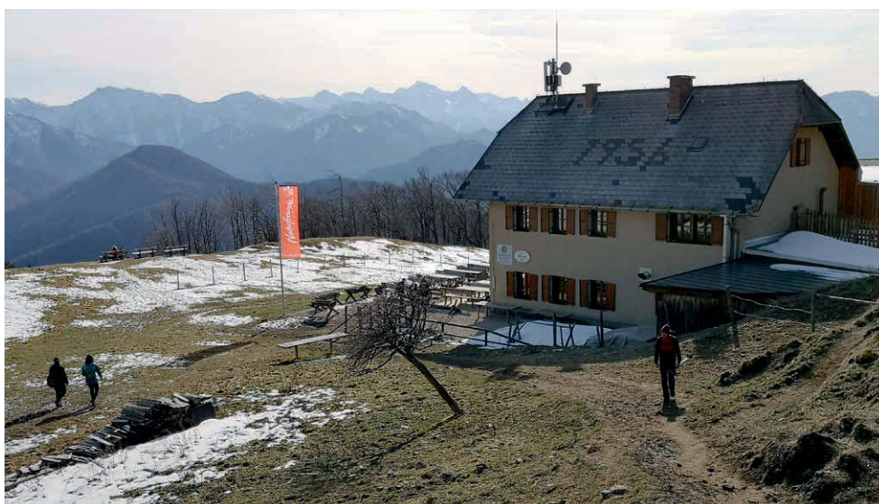
Sanierungsbedürftige Schutzhütte im Alpenvorland
