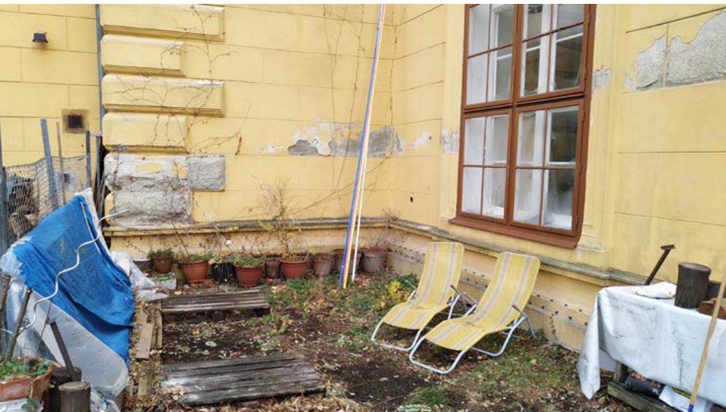
Südpavillon der Praterateliers, Zustand vor der Sanierung
