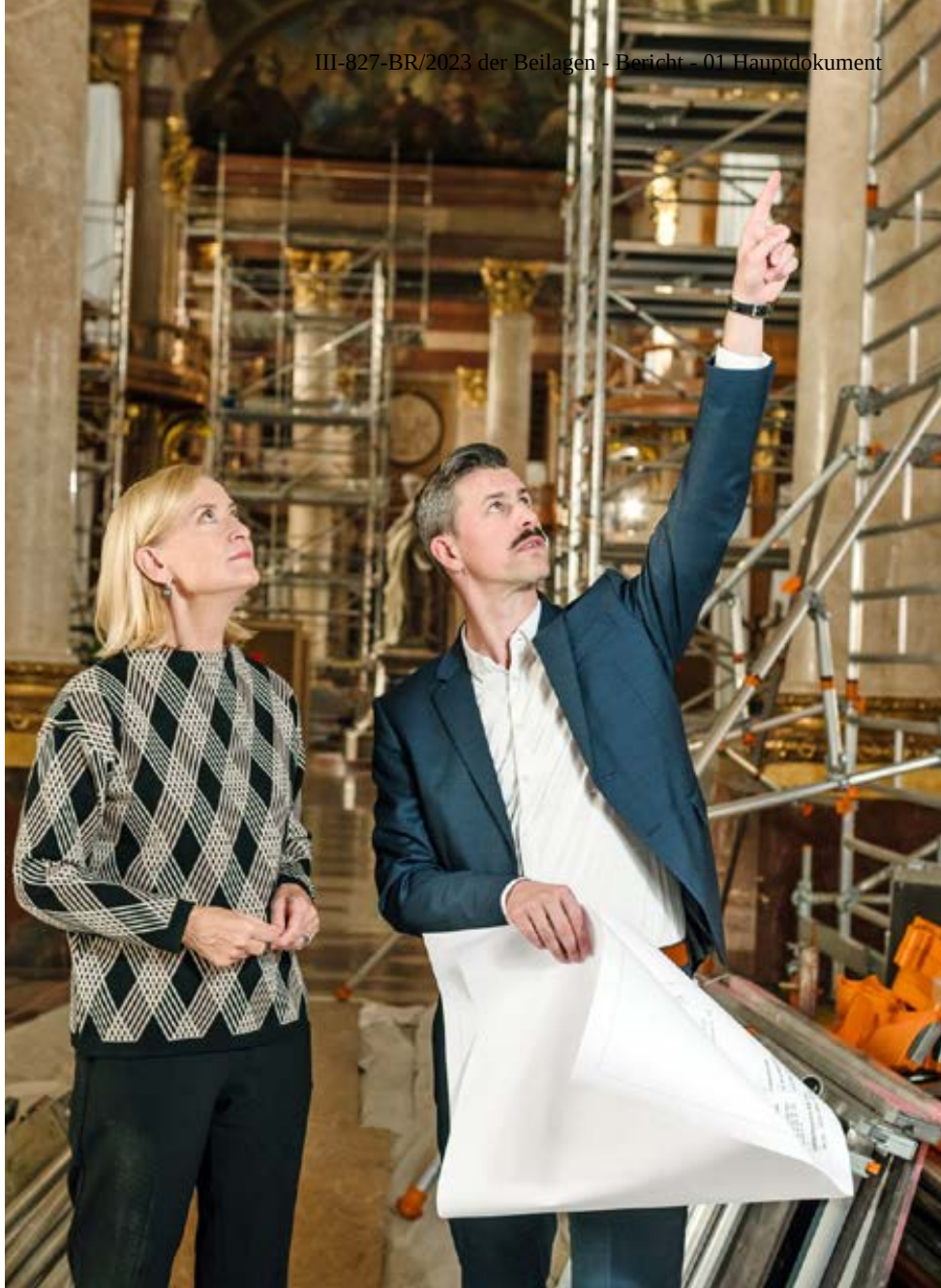
Renovierungsarbeiten im Prunksaal
