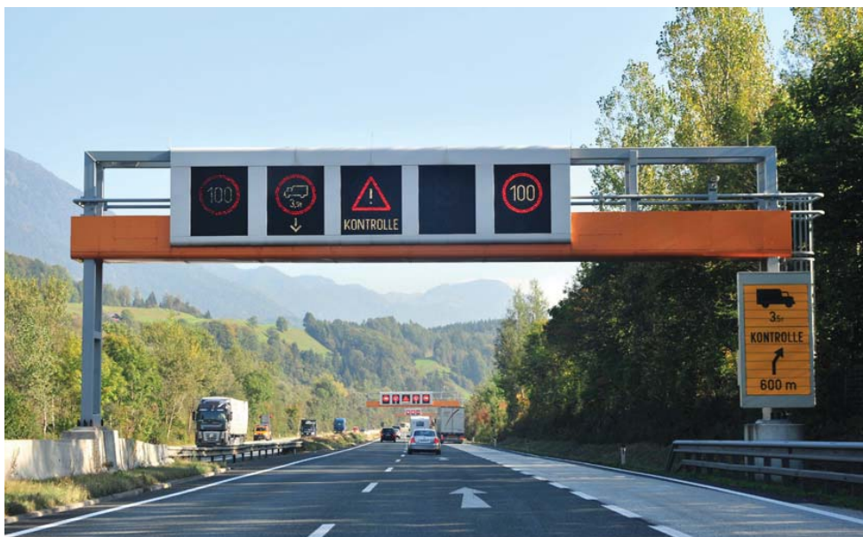
Abbildung 25: Variable Message Sign (VMS) auf dem Autobahnnetz © ASFINAG
