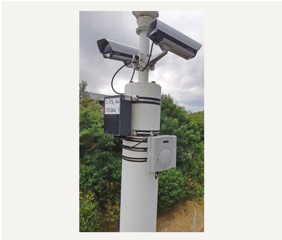
Abbildung 26: Verkehrskameras und C-ITS-Roadside-Unit © ASFINAG
