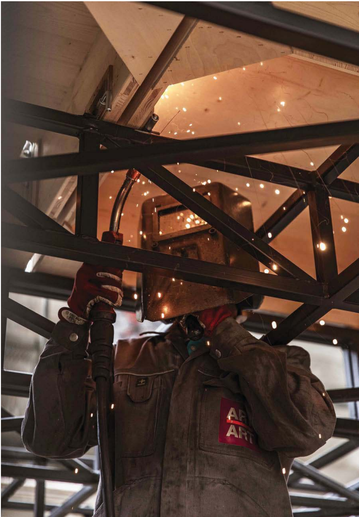
Blick in die Werkstätten, Metallbau
