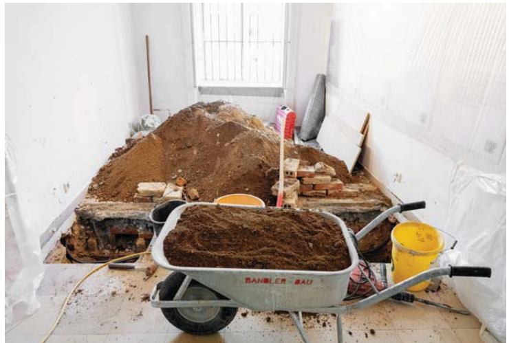
Volkskundemuseum Wien, Vorbereitungsarbeiten für die Sanierung
